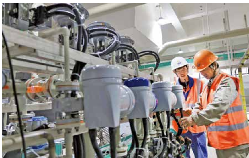
安装前驱体车间反应釜仪表
