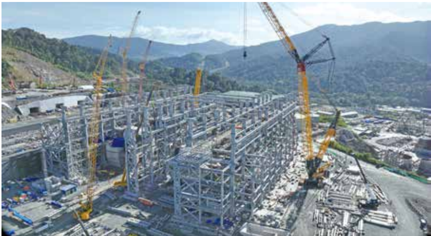
3100 区磨矿车间施工现场
