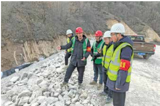
工作人员检查坝边坡安全
