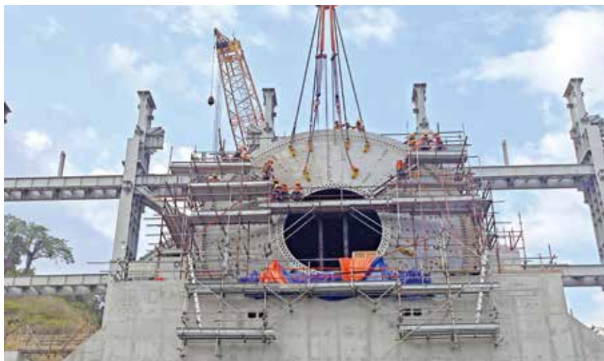
球磨机安装现场
