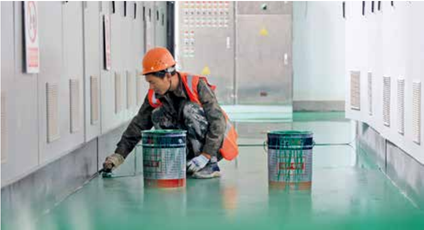
四氧化三钴车间二层巡检室环氧地坪面漆施工
