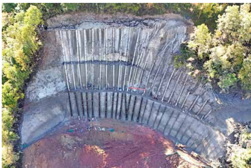
昆勘院金鼎锌业练登大沟排土场泥石流专项治理 EPC 项目 H65 滑坡建设现场
