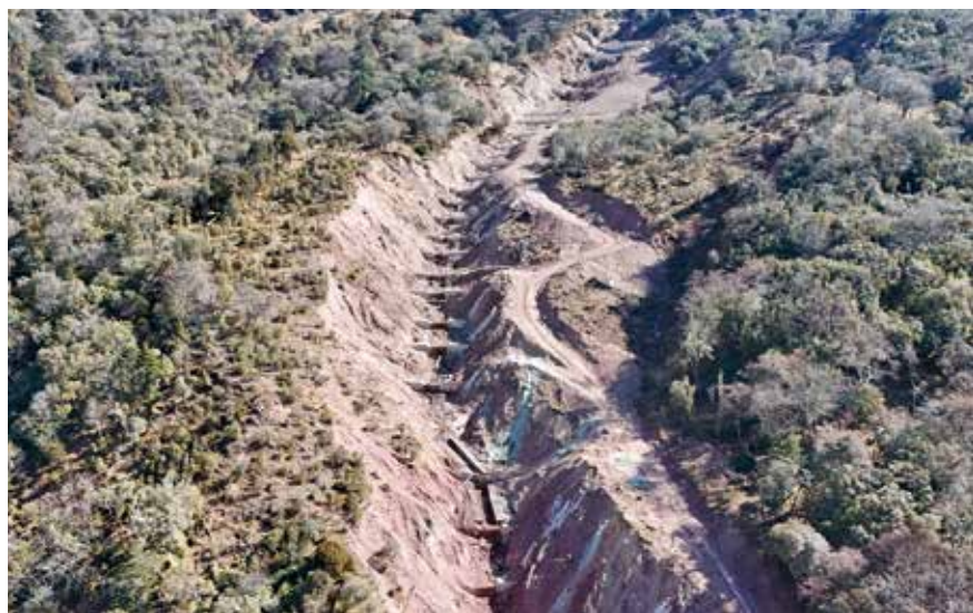
昆勘院金鼎锌业练登大沟排土场泥石流专项治理 EPC 项目多级潜坎建设现场
